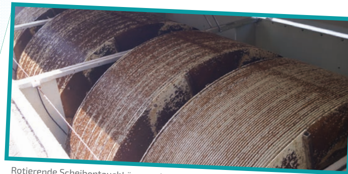
Rotierende Scheibentauchkörper mit biologischem Rasen
